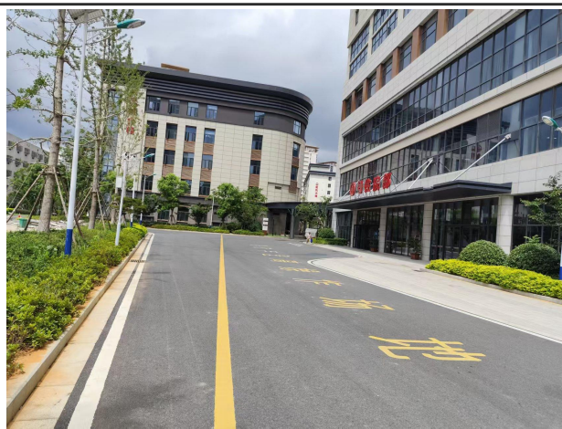
医技住院楼南侧
